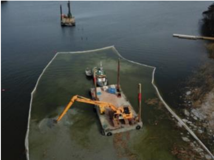
Figur 4-3 Exempelbild över siltgardin som nyttjas i samband med muddring.
